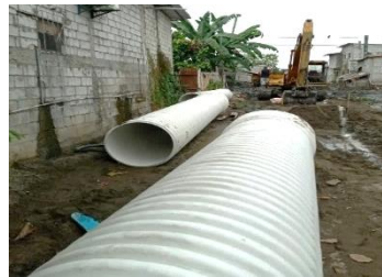
Instalación de tubos de 350mm Coop. Buenos Aires.
