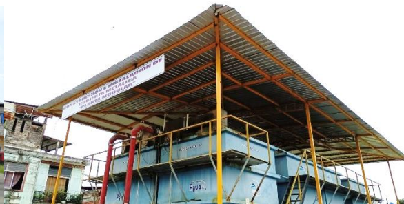
Cubierta metálica de la Planta Modular.
