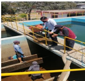
Cambio de arena grava de los filtros, limpieza de reservorios, reparaciones de bombas de las plantas Potabilizadoras.
