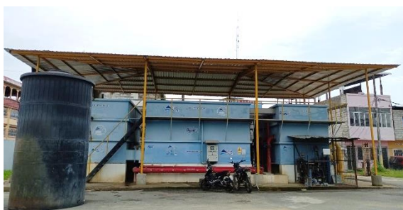
Cubierta metálica de la Planta Modular.
