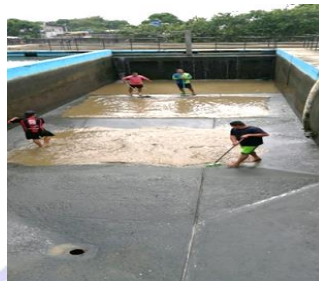
Cambio de arena grava de los filtros, limpieza de reservorios, reparaciones de bombas de las plantas Potabilizadoras.
