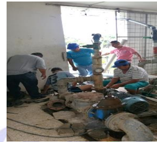
Cambio de arena grava de los filtros, limpieza de reservorios, reparaciones de bombas de las plantas Potabilizadoras.
