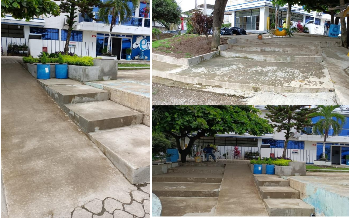
Construcción de rampas y escalinatas, para un mejor acceso de los usuarios.
